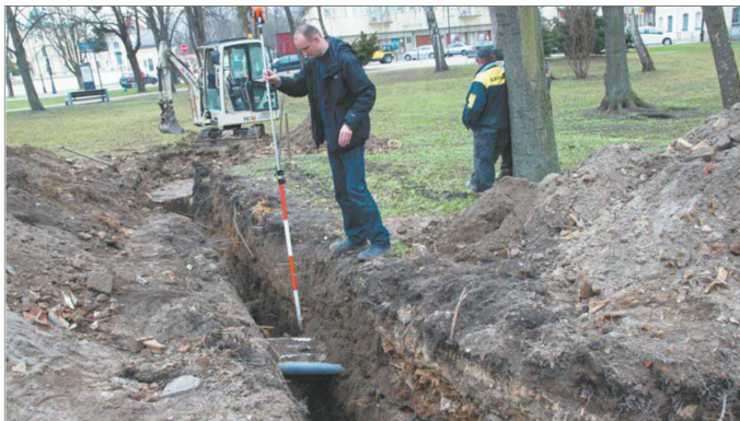
Robotnicy kopią w pobliżu miejsca, gdzie zlokalizowany jest zapomniany kanał pod ulicą Kilińskiego
